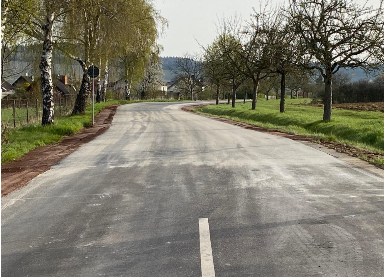
Neu fertig asphaltierte K86 von der ED-Tankstelle bis einschließlich Lieserbrücke Maring
